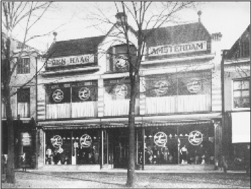
Foto pand Sneek Gebrs. Lampe aan het Grootzand
